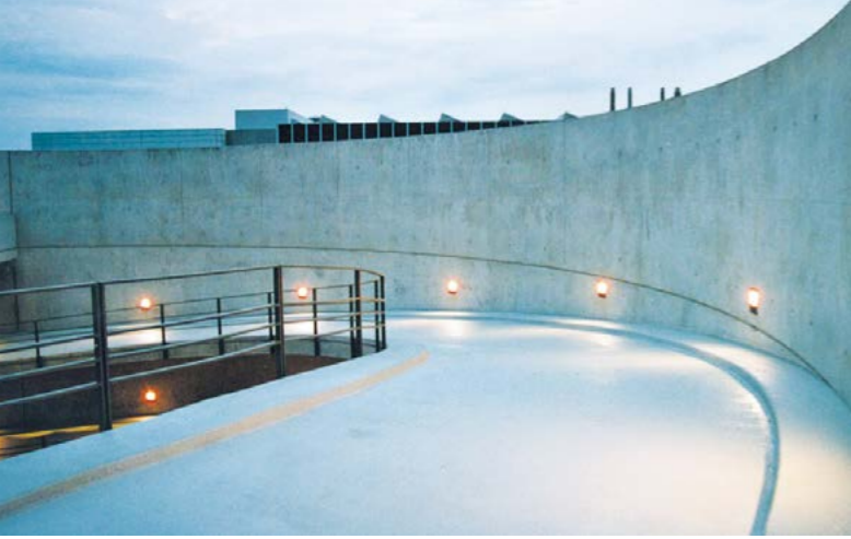
Resim 3, 4: Açık yerüstü Burda rampalı-otoparkının çatı katı bağlantısı. Offenburg, Almanya.
